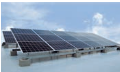
太陽光発電設備
