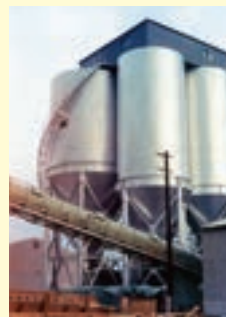
クレーサイロと自動調合プラント
