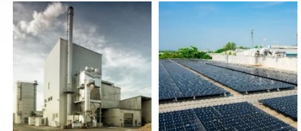
バイオマス発電・太陽光発電 等
